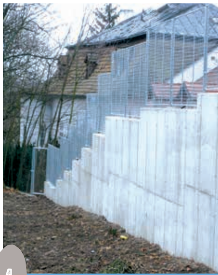
4 rekonstrukce opěrné zď
